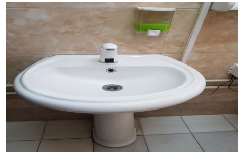
نصب شیرهای چشمی
